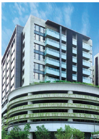
潤泰建設京采
